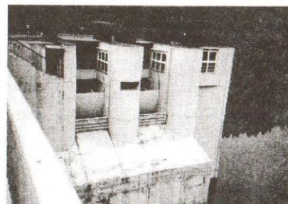
Obr. 3. Pohled na sdružený objekt dolní nádrže
