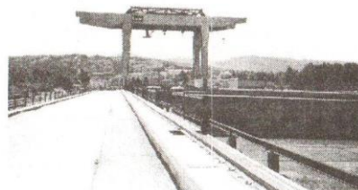
Obr. 3. Elektrárnská část přehrady s portálovým jeřábem. Pod portálem mezi pojezdovými kolejnicemi jsou vidět posuvná "střešní okna" jejichž rozvěvením je zajištěn přístup jeřábu k turbínám a generátorům.
