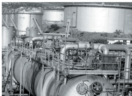
Obr.5 Atmosférická destilace ropy – rekonstrukce odsolovače, BRC Sýrie
