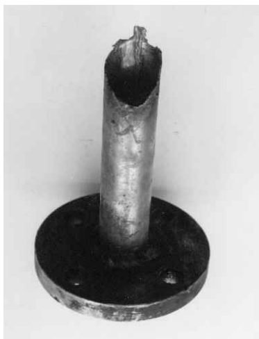
Ukázka havarovaného dílu
