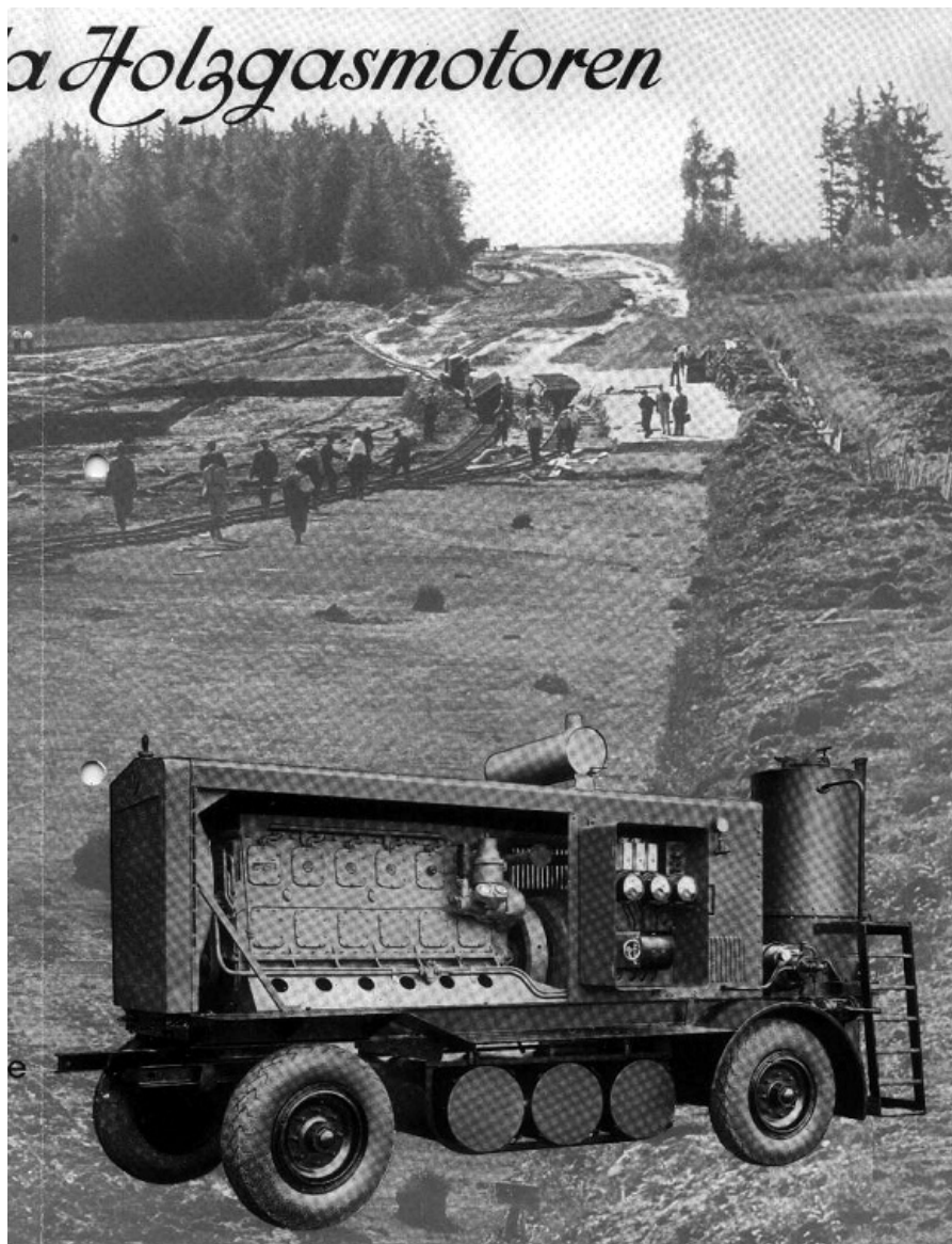
Pojíždňá elektrárna s plynovým motorem Škoda
