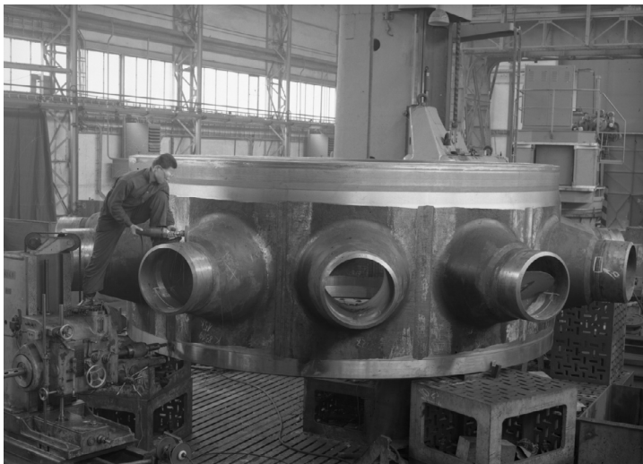
Výroba hrdlového prstence pro jadernou elektrárnu A-1 v hale 1 v Plzni-Bolevci (60. léta 20. století)
